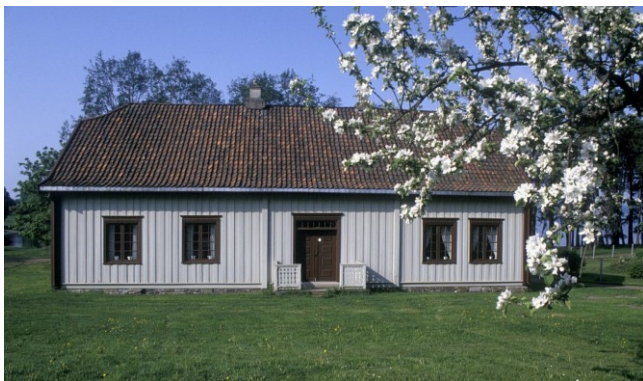
Stor-Deglumbygningen i Rosenlundvika
